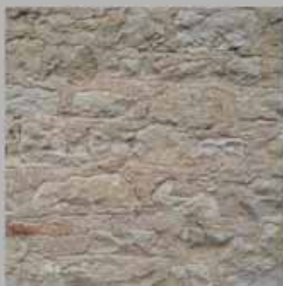
intonaco spianato e battuto stilato con lama
