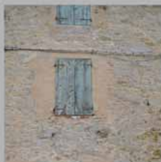
intonaco spianato e battuto stilato con lama
