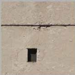
intonaco spianato e battuto a cazzuola
