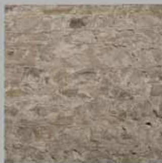
intonaco spianato e battuto stilato con lama
