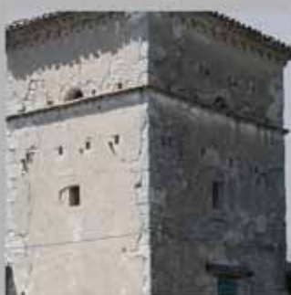
intonaco a frattazzo
