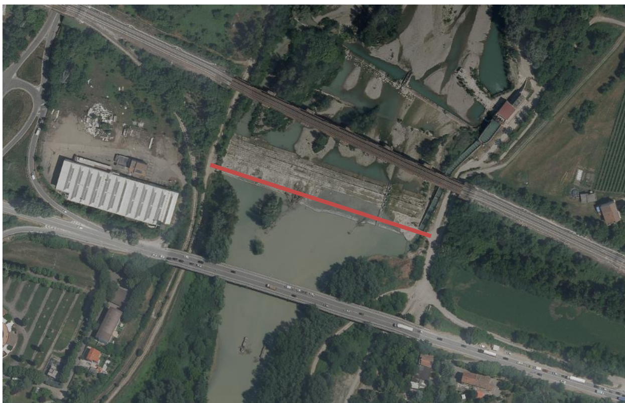
Figura 10 - Vista della disconnessione idraulica a valle del viadotto della Via Emilia (linea rossa)
