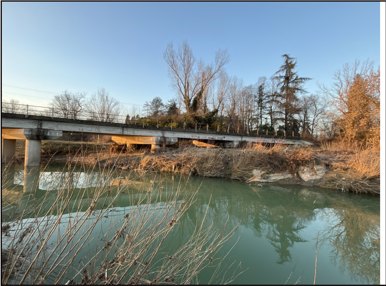
Fig. 10 - Torrente Tresinaro con ponte ferroviario
