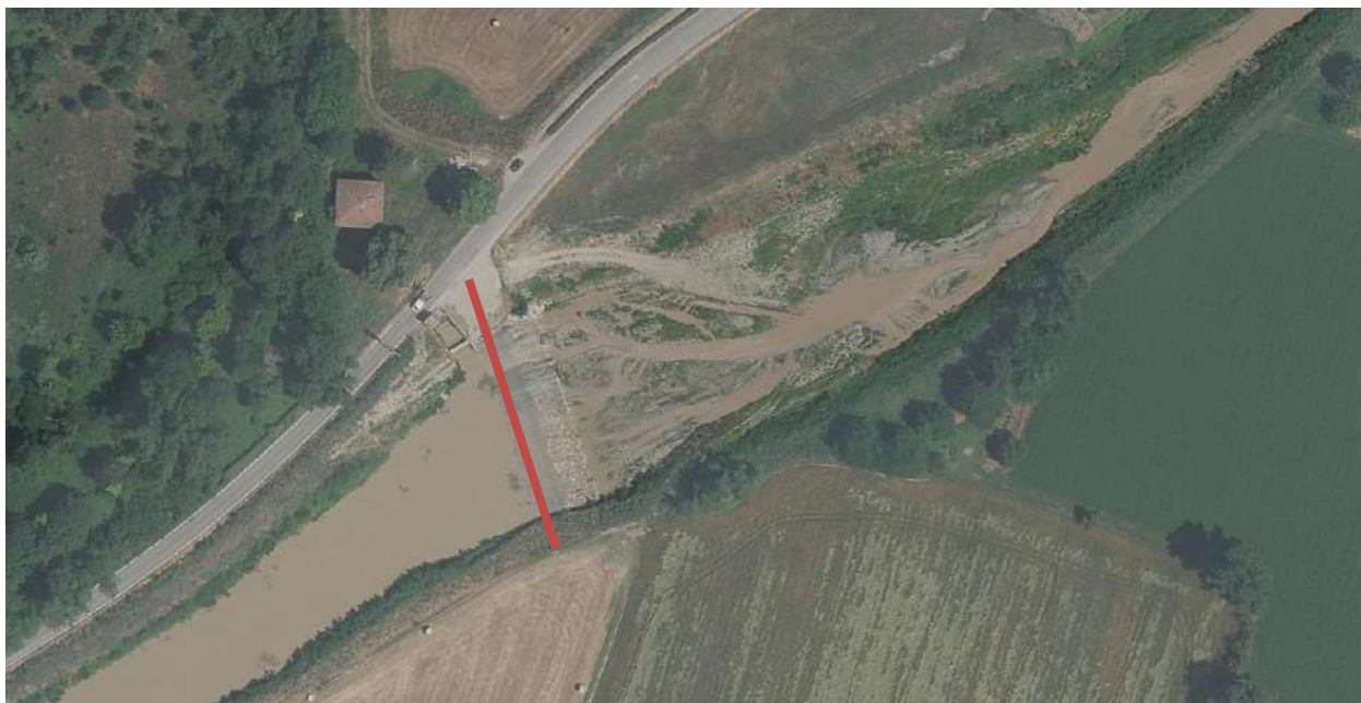
Figura 9 - Vista dell'elemento di disconnessione idraulica lungo il torrente Tresinaro (a monte dell'abitato di Rubiera)
