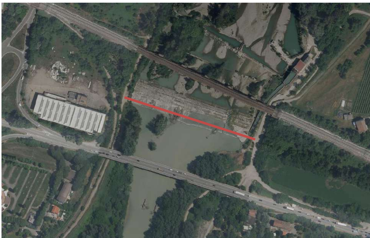
Figura 8 - Vista della disconnessione idraulica a valle del viadotto della Via Emilia (linea rossa)
