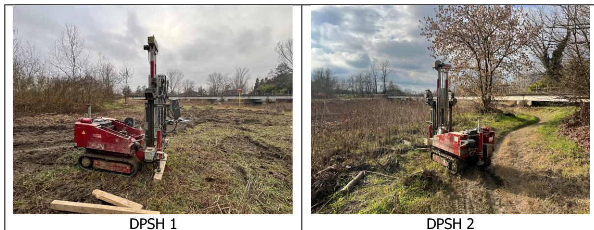
Fotografia 3 – Piazzamento delle prove penetrometriche dinamiche DPSH
