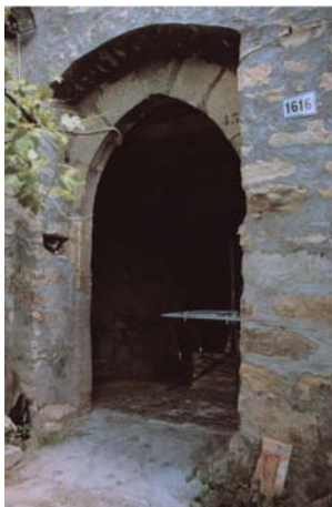
A. Portale a sesto acuto di accesso alla rocca
