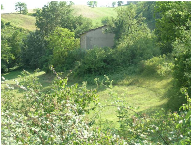
Ripresa esterna dell'edificio da nord
