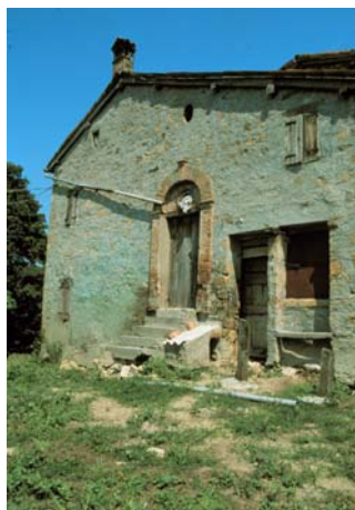
A. Edificio centrale
