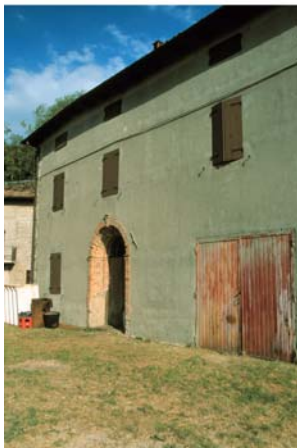
B. Edificio principale Lato a valle
