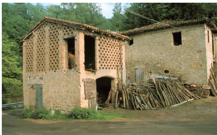
G, H. Edifici Agricoli
