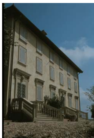
C. Edificio padronale ristrutturato
