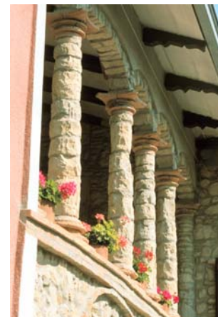
A. Colonne della Loggia
