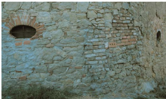
A. Particolare delle finestrelle ovali
