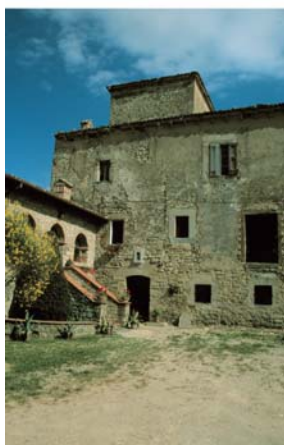
Palazzo sul lato della corte
