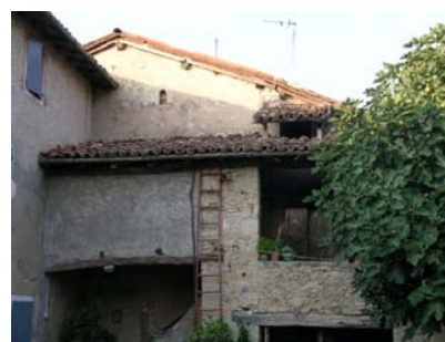
Particolare della casa torre con finestrella monolitica
