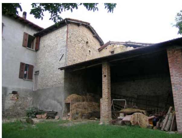
Lato esterno ovest della corte
