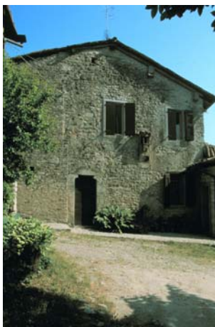
C. Edificio principale
