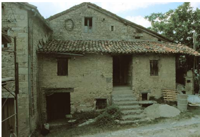
Facciata casa torre con balco quattro-cinquecentesco
