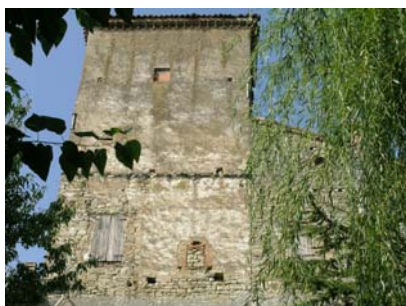
B. Torre lato est
