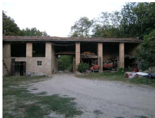
Lato interno dell'accesso
