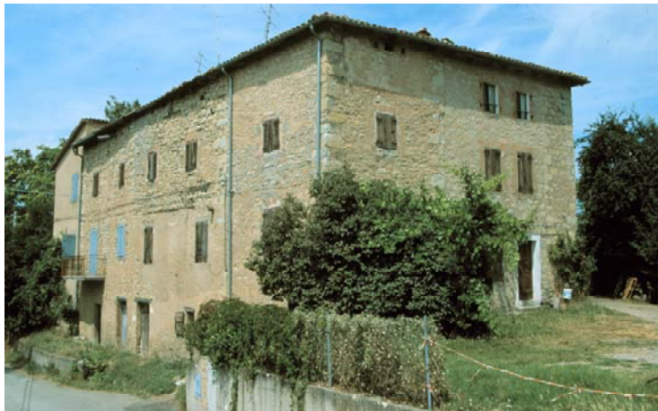
C. Edificio principale da sud
