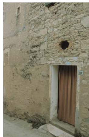
Edificio cinque-sei centesco con finestre tamponate
