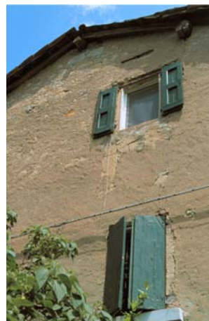
Casa Torre – finestra cinquecentesca tamponata
