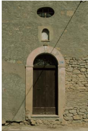
B. Portale in laterizio intonacato
