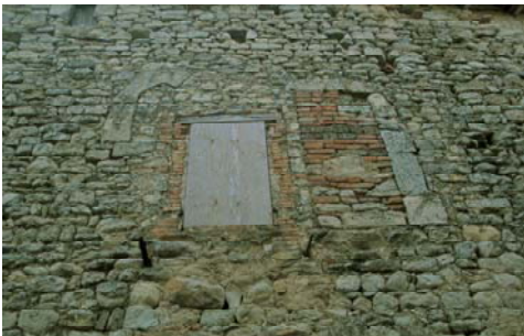
C. Lato NE, tracce di portali e finestre tre-quattrocenteschi
