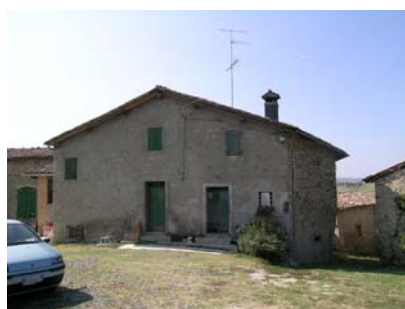
A, B,E. Lato a monte
