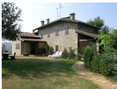
C. Lato posteriore torre ristrutturata
