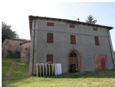
A. Stalla fienile ristrutturata B. Casa padronale lato a valle
