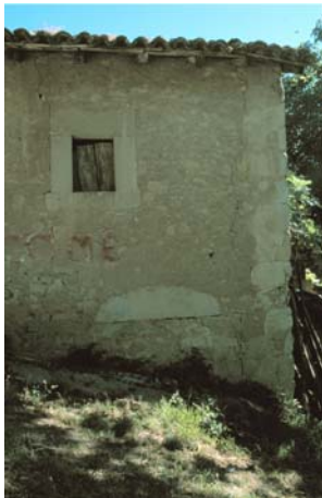
B. Fabbricato con portale quattrocentesco a mensole tamponato
