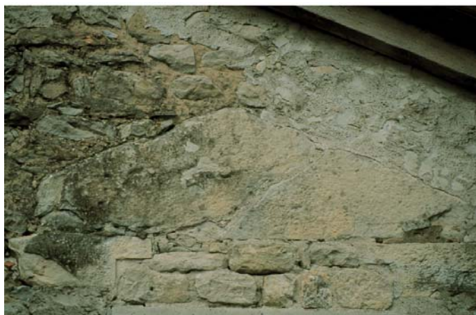
C. Edificio principale, portale a mensola con architrave triangolare tamponato
