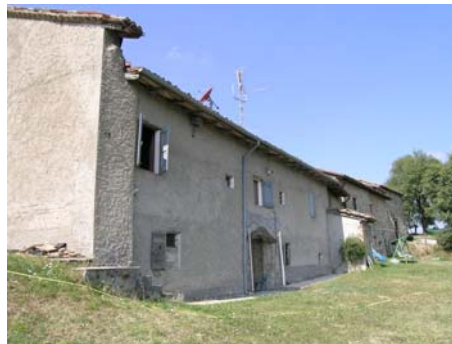
A. Lato esterno con volta per passaggio coperto
