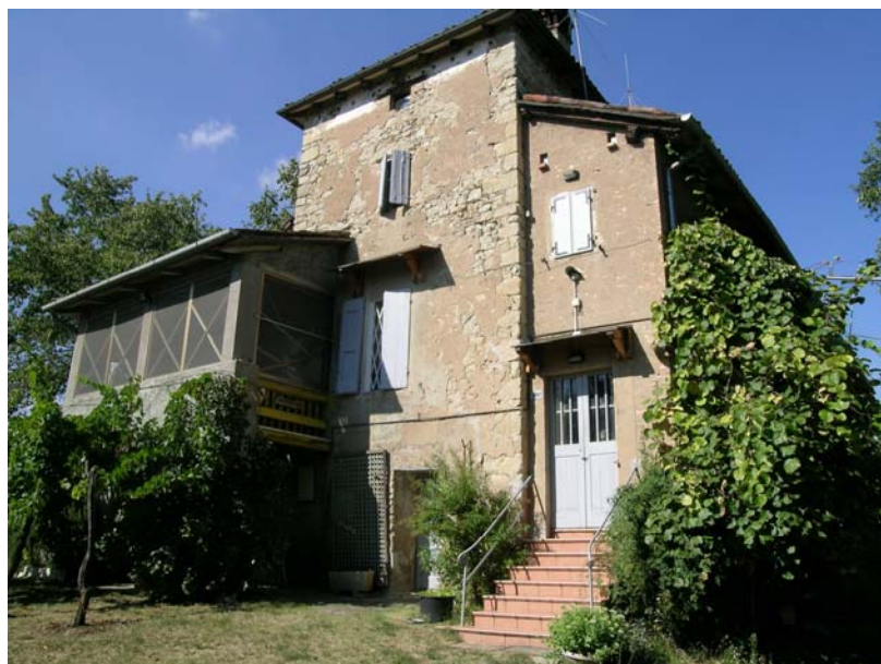
Balchi d'accesso trasformati
