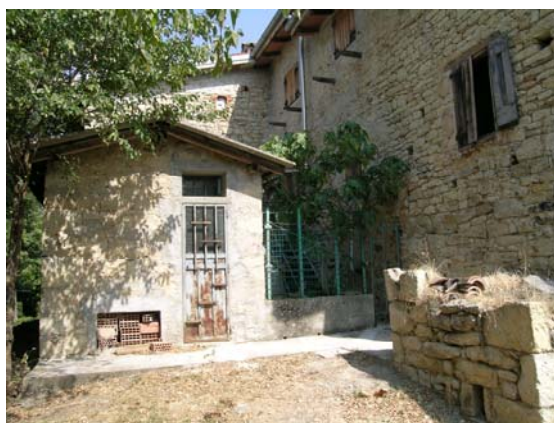
A. Lato ovest
