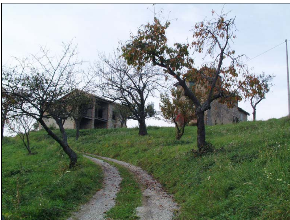
Edifici A e B
