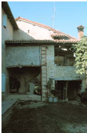
Facciata interna casa torre con balchio
