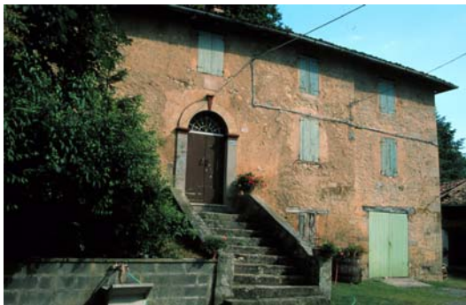
A. Facciata Casa Padronale
