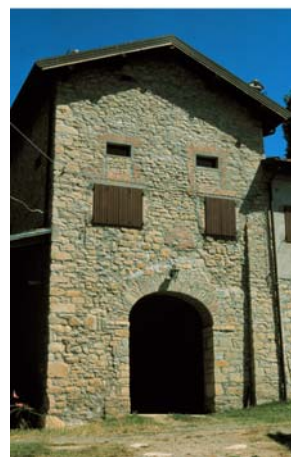
C. Torre ristrutturata
