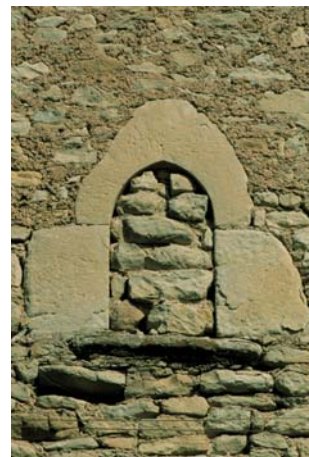
A. Casa torre. Finestra a sesto acuto
