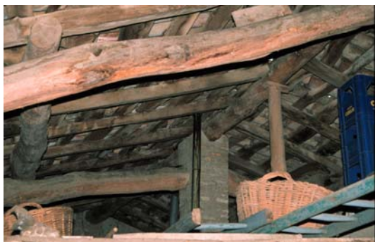
B. Portico - orditura lignea della copertura
