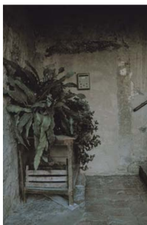
Portale tritico tamponato
