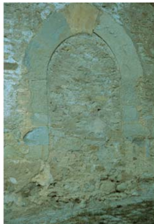
B. Casa Montecuccoli Portale a sesto acuto
