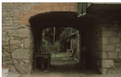
A. Passaggio coperto
