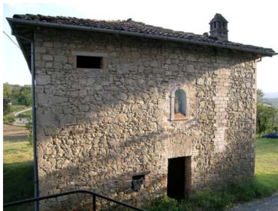
D. Lato nord
