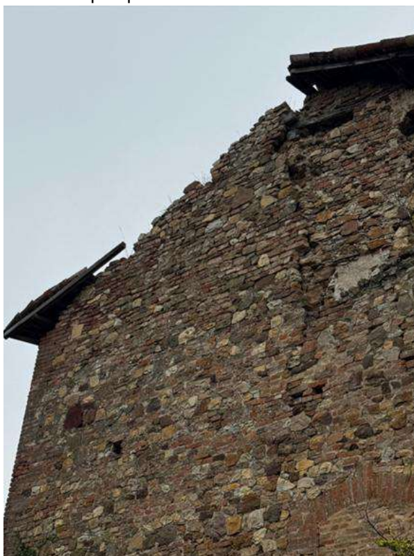
16 - Particolare parte superiore prospetto ovest
