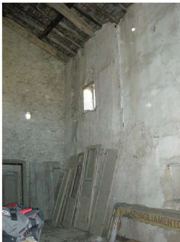
29 - Interno piano superiore
