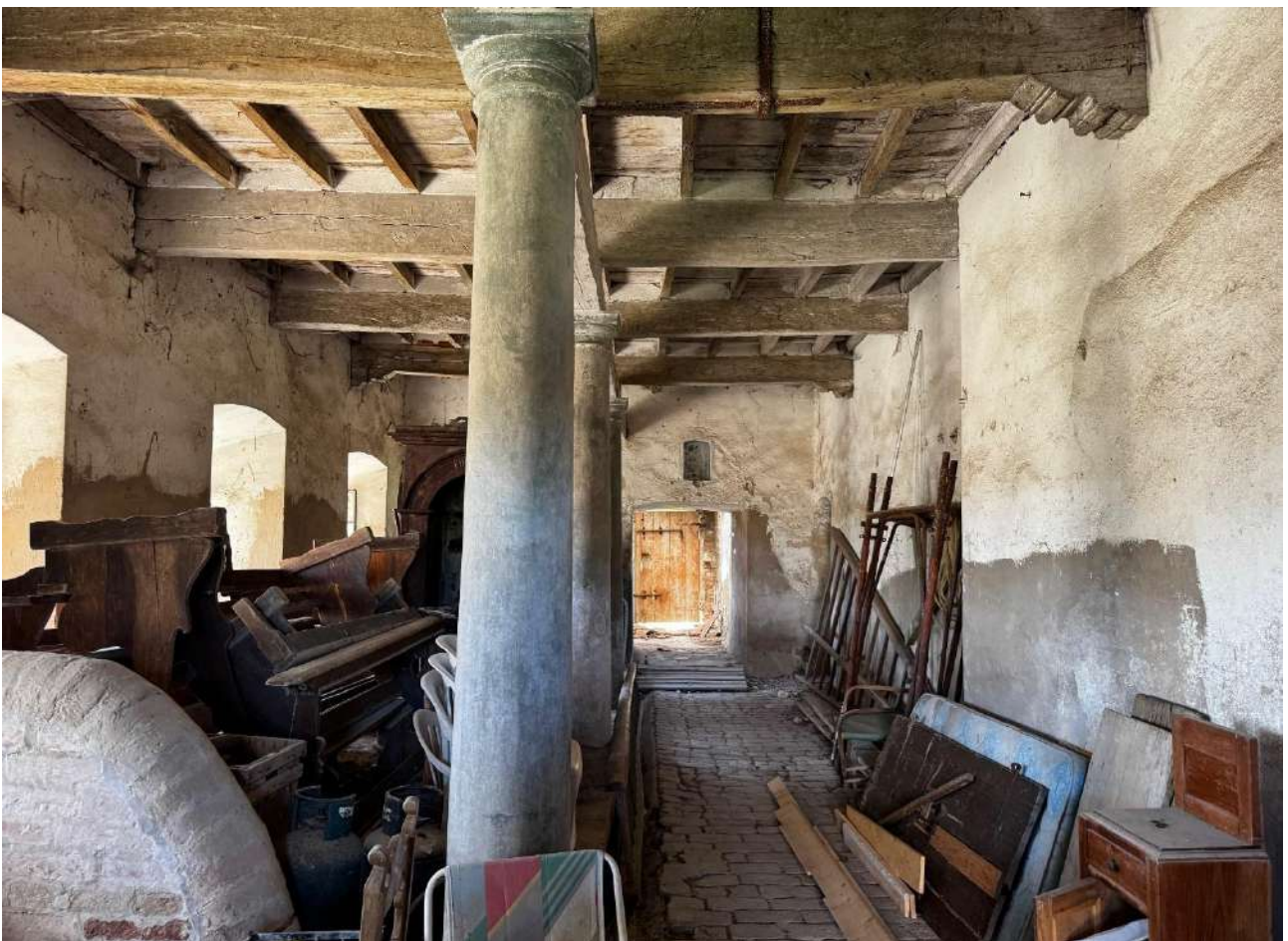
26- Interno.Ambiente a nord
