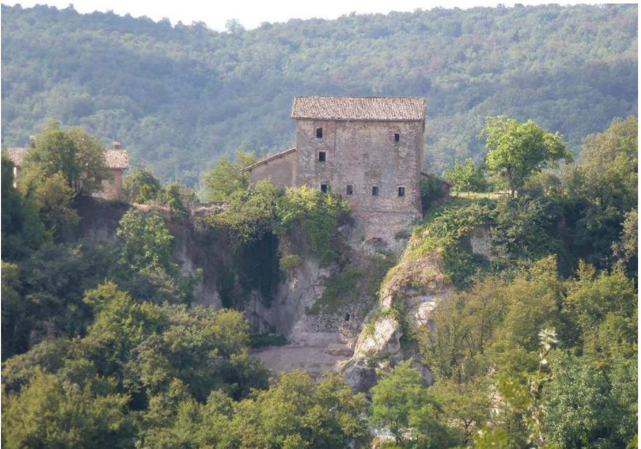
2 -Vista del complesso da nord
