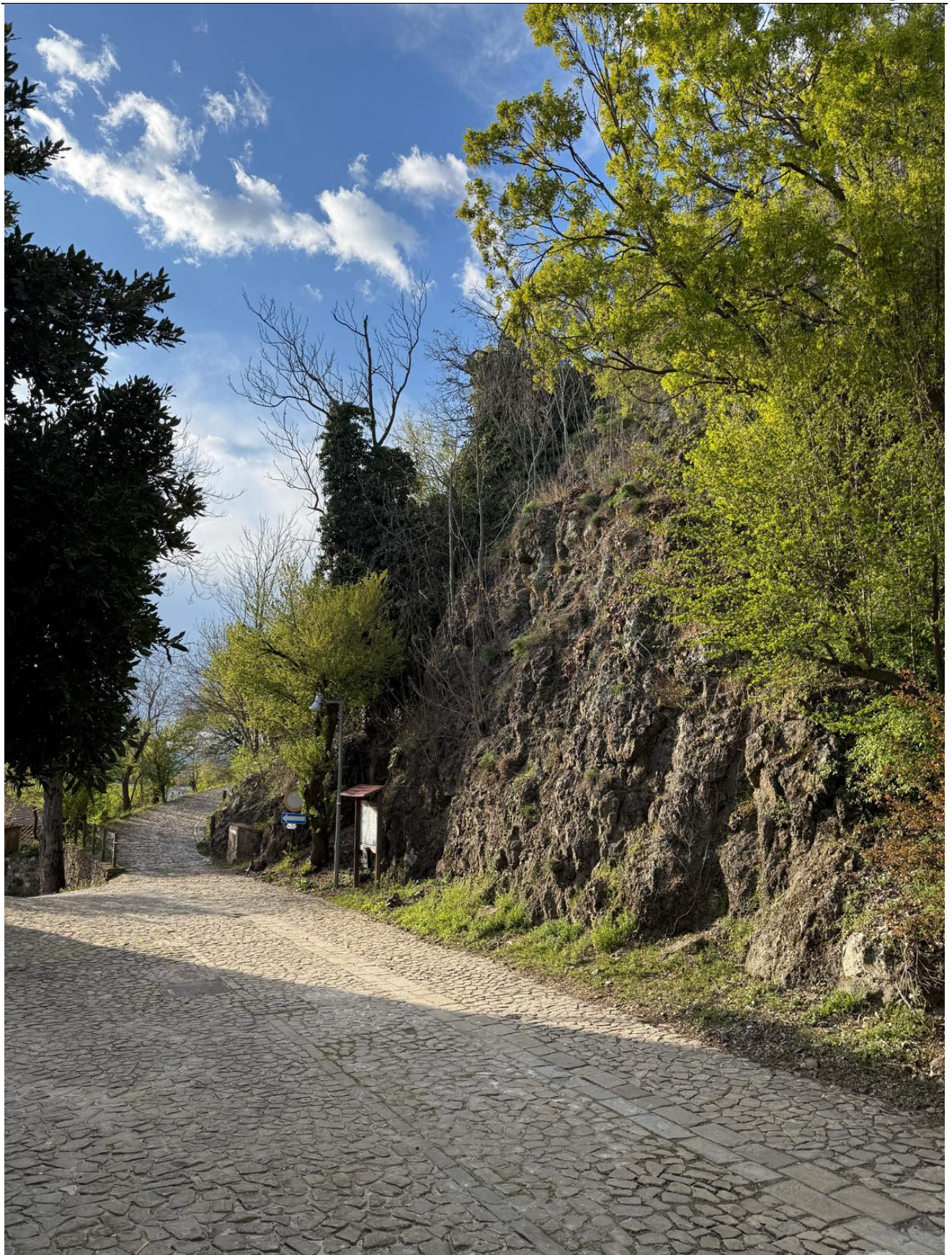
Figura 3 Istallazione della barriera paramassi subito a monte del primo fronte roccioso
