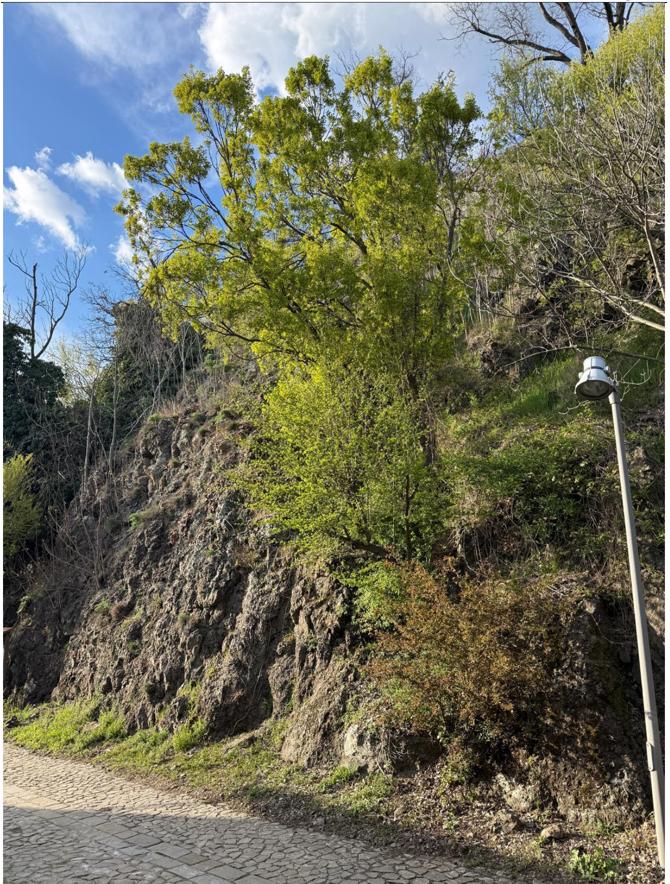
Figura 4 Installazione della barriera paramassi subito a monte del primo fronte roccioso
