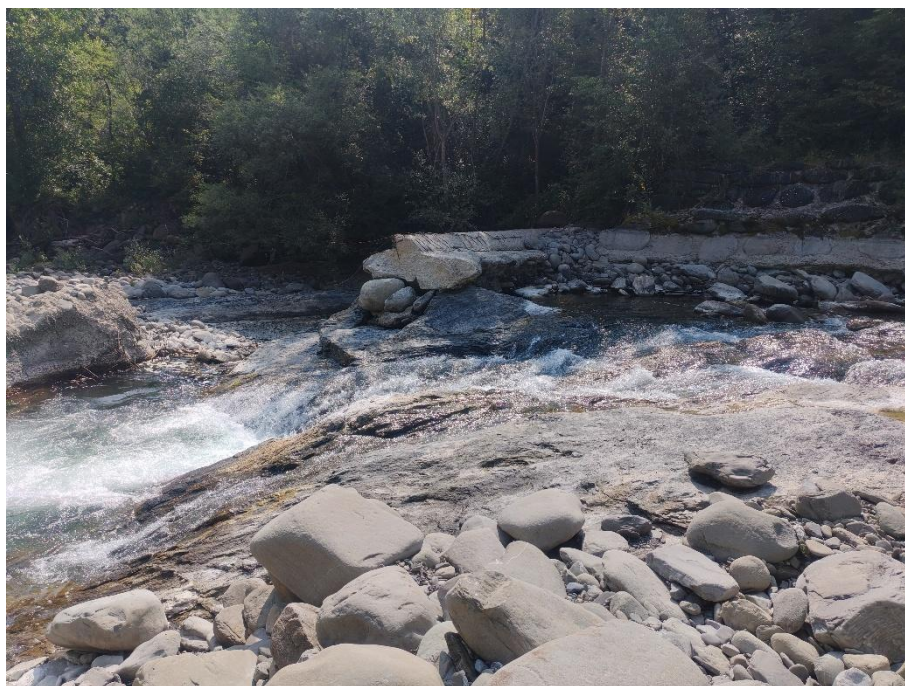
Figura 21 – Briglia posta sul Torrente Leo oggetto di progettazione della scala di risalita per l'ittiofauna (sopra, briglia nell'anno 2023, sotto la briglia parzialmente crollata nell'anno 2025)
