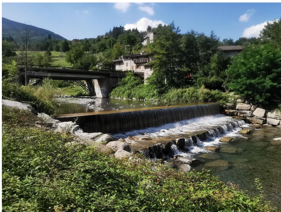
Figura 20 – Briglia posta sul Torrente Fellicarolo oggetto di progettazione della scala di risalita per l’ittiofauna
