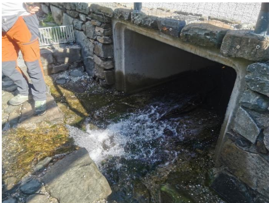
Figura 4 – Scatolare presente a valle della gaveta di uscita del lago
