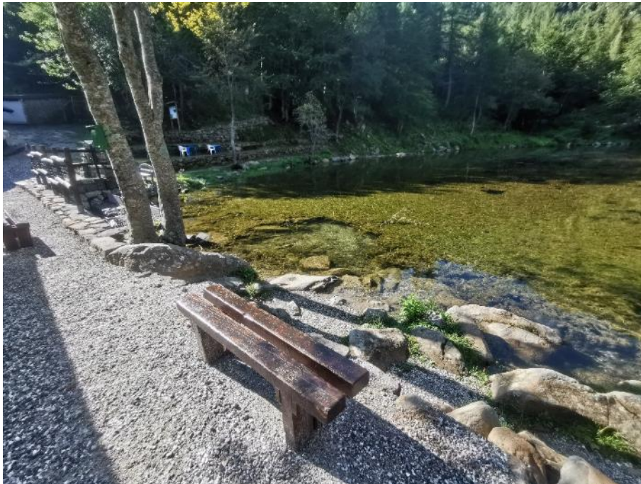
Figura 2 – Zona di uscita del lago nello stato attuale
