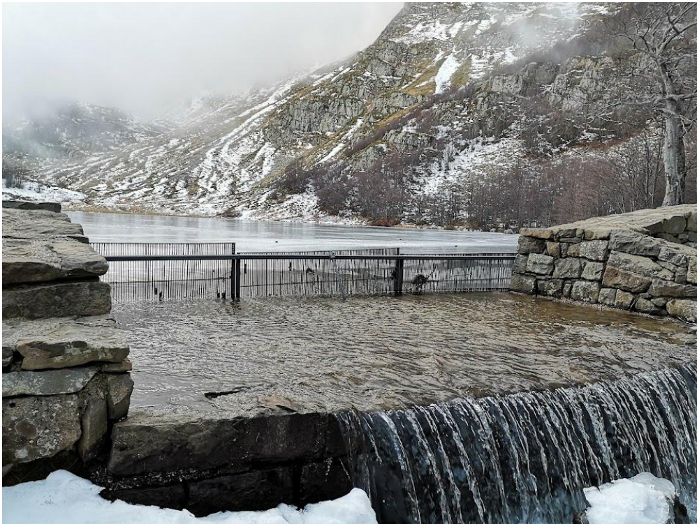
Figura 10 - Manufatto di scarico e funzionamento attuale a sfioro
