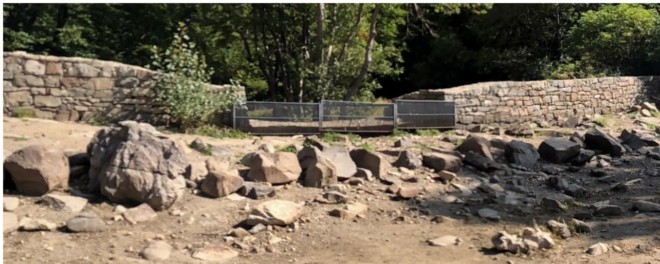
Figura 8 - Manufatto di sfioro attuale
