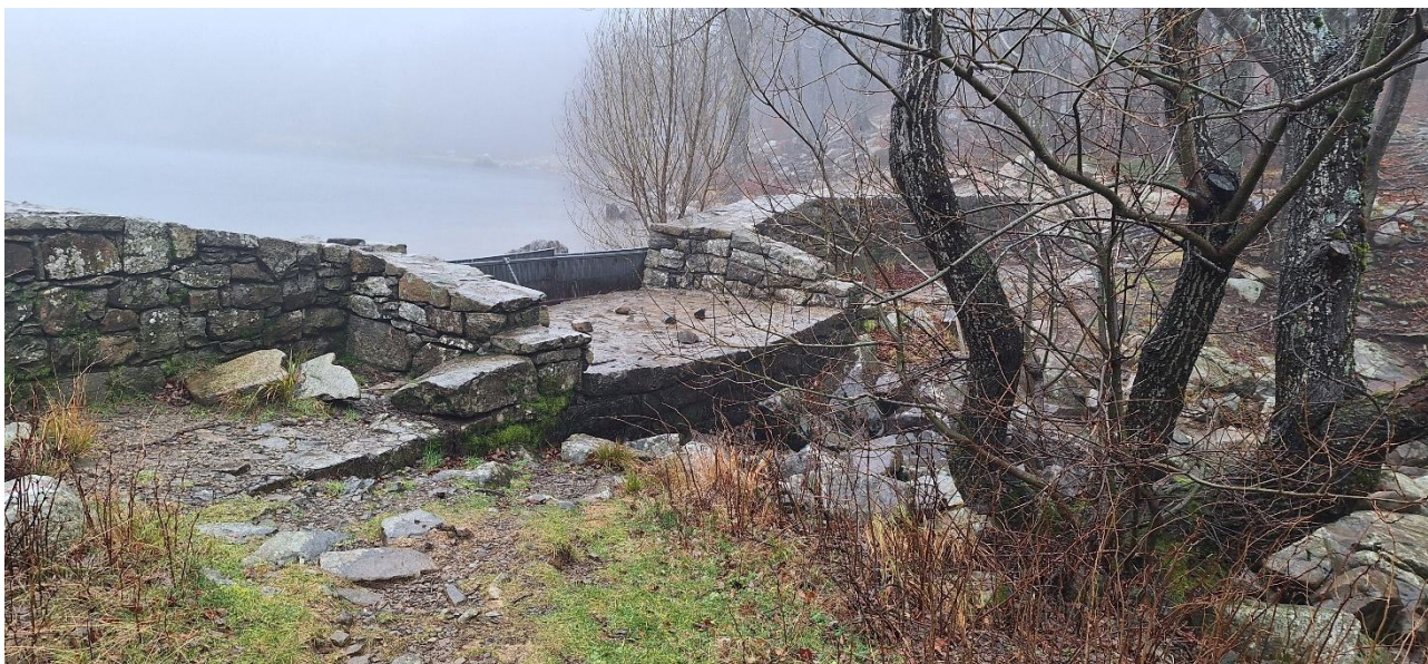
Figura 6 - Manufatto di sfioro attuale
