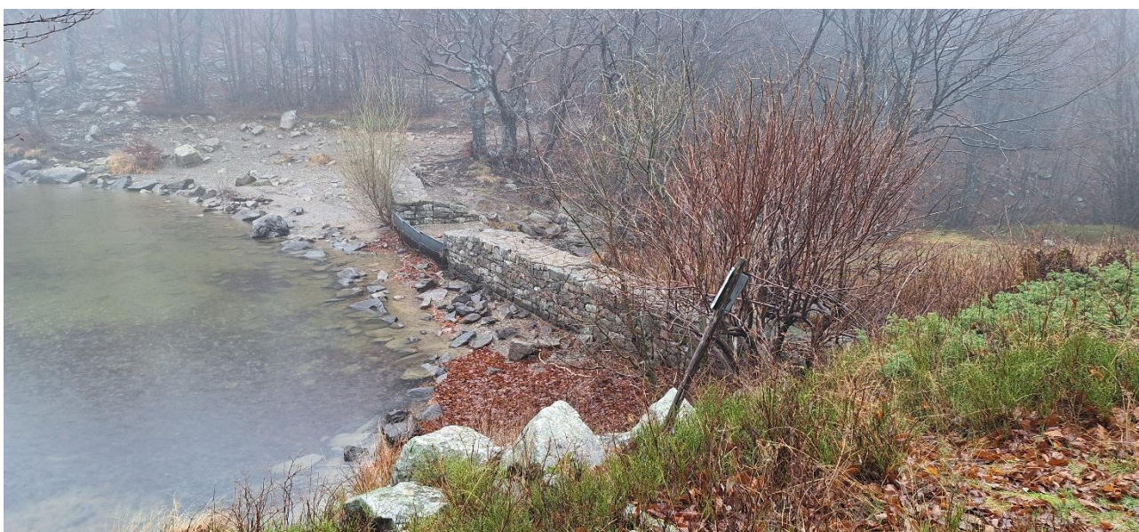
Figura 7 - Manufatto di sfioro attuale
