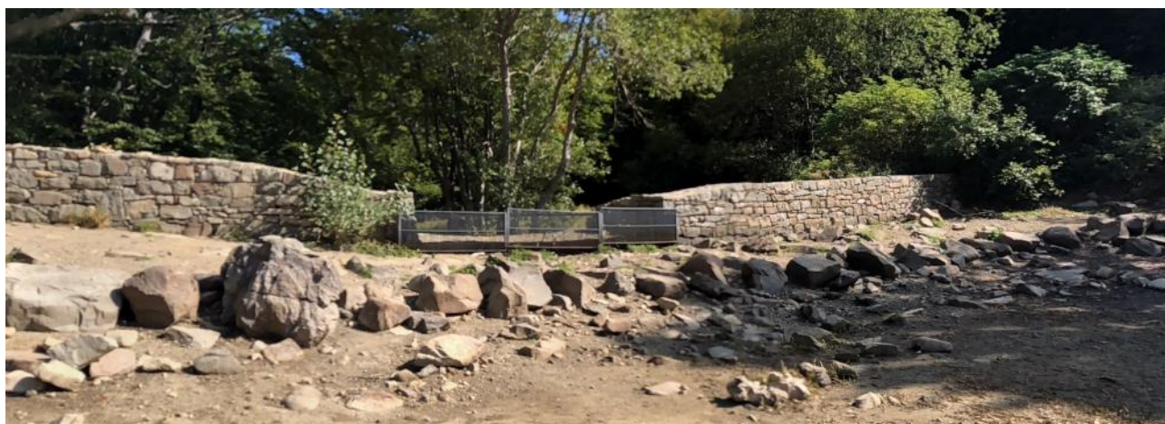
Figura 2 – Manufatto di sfioro delle acque del Lago Baccio
