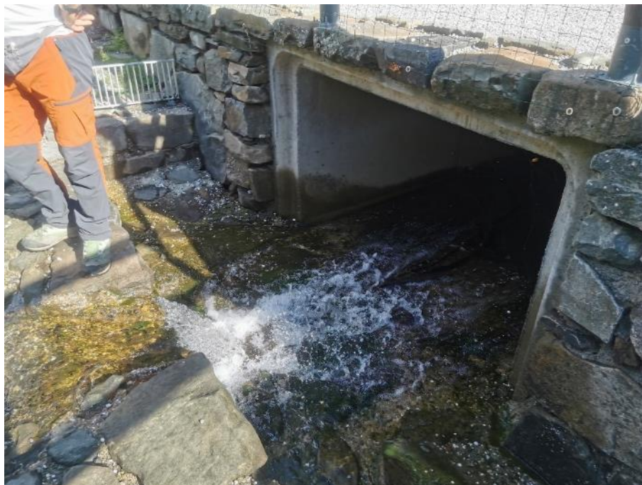
Figura 48 – Scatolare presente a valle della gaveta di uscita del lago
