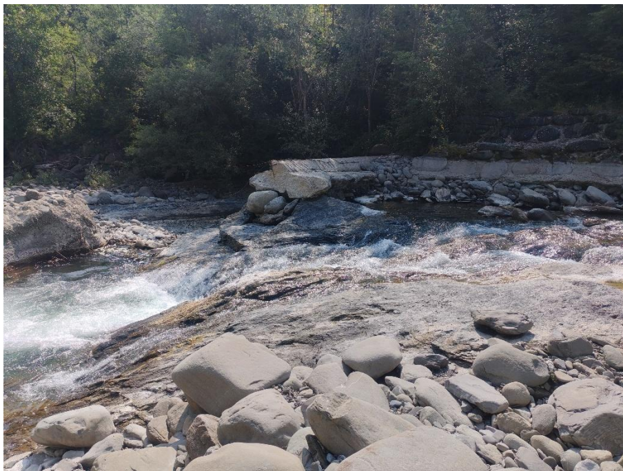
Figura 51 – Briglia posta sul Torrente Leo oggetto di progettazione della scala di risalita per l'ittiofauna (sopra, briglia nell'anno 2024, sotto la briglia parzialmente crollata nell'anno 2025)
