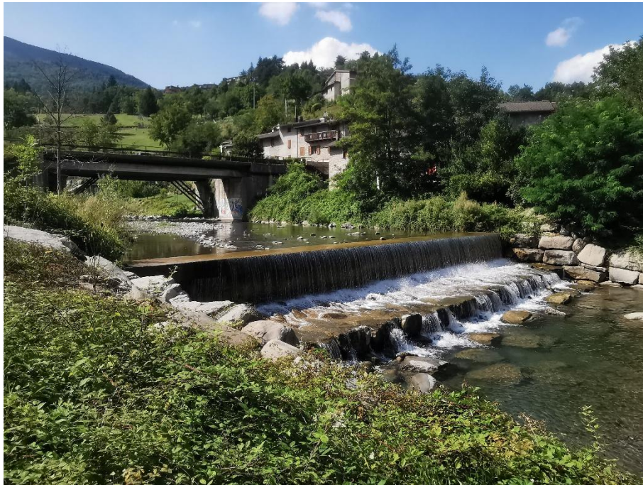
Figura 13 – Briglia lungo il Torrente Fellicarolo oggetto di intervento
