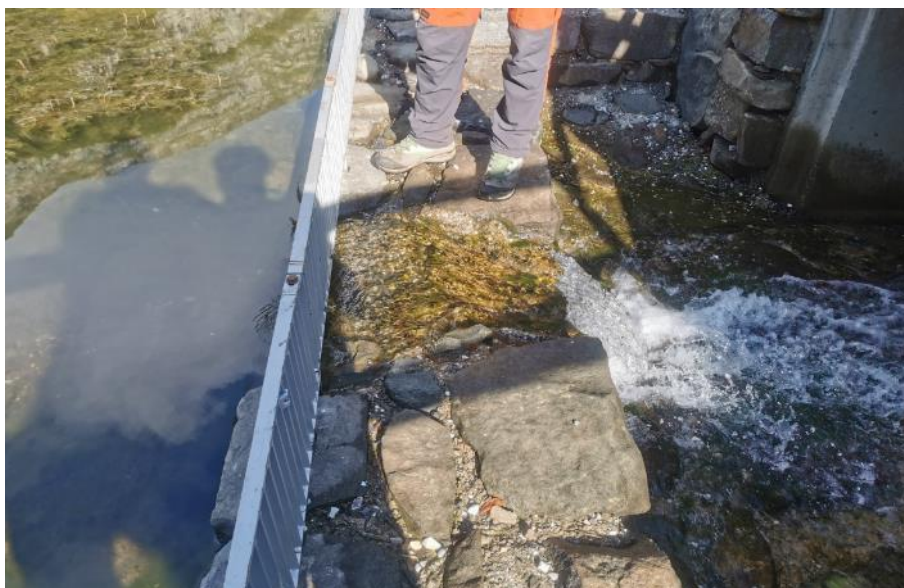
Figura 47 – Briglia con gaveta di uscita del lago nello stato attuale
