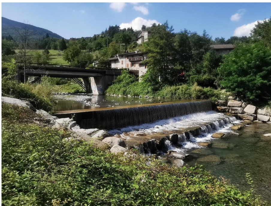
Figura 50 – Briglia posta sul Torrente Fellicarolo oggetto di progettazione della scala di risalita per l'ittiofauna
