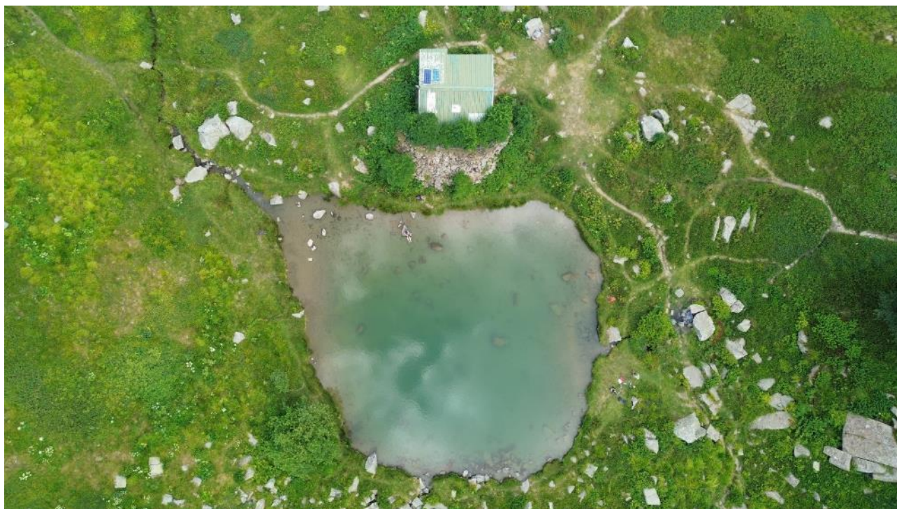
Figura 9 – Lago Turchino e rifugio (ripresa aerea da drone)
