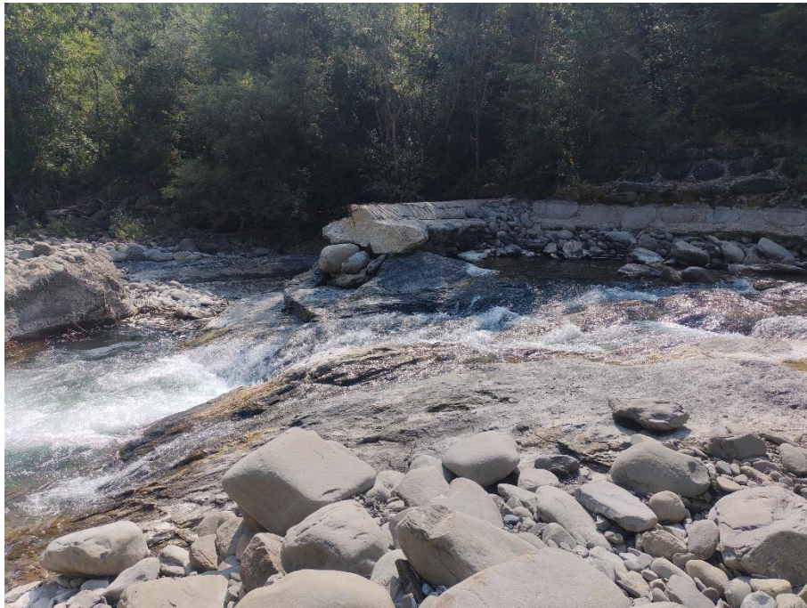
Figura 15 – Briglia lungo il Torrente Leo oggetto di intervento (anno 2024)
