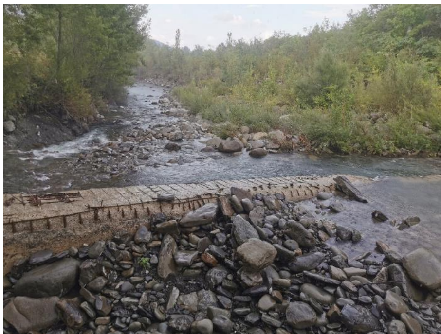
Figura 16 – Briglia sifonata lungo il Torrente Leo a valle di quella oggetto di intervento
