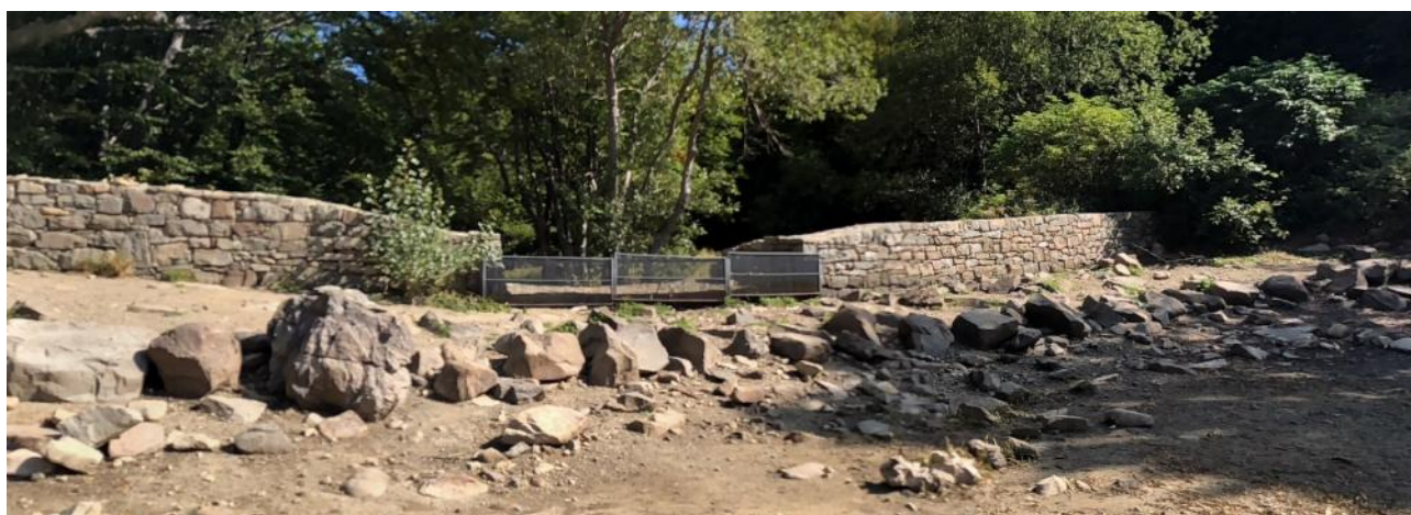
Figura 41 – Manufatto di sfioro delle acque del Lago Baccio
