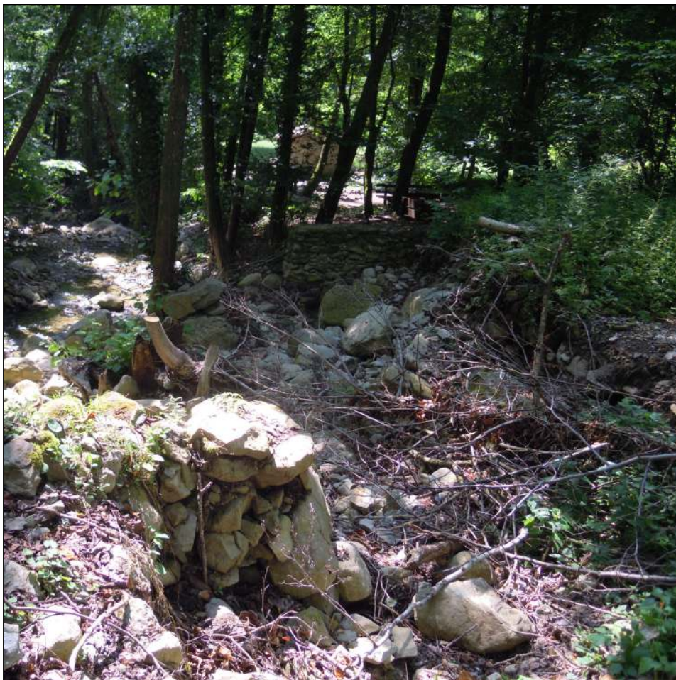
Foto n. 3 - Veduta del muro n.1 da ricostruire con antistante scogliera di protezione da realizzare (tratto Rio Vallecchie a monte del Mulino della Riva).
