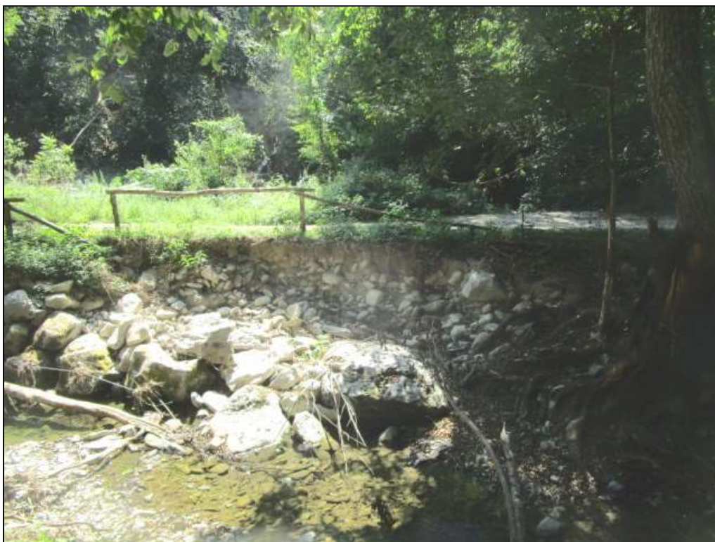
Foto n. 5 - Veduta della scogliera esistente a protezione della strada di accesso al Mulino della Riva che si intende ripristinare e consolidare con funi di ancoraggio.
