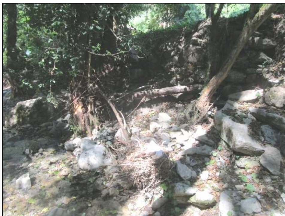
Foto n. 4 - Veduta del muro n.2 da ricostruire con antistante scogliera di protezione da realizzare (tratto Rio Vallecchie a valle del Mulino della Riva)..
